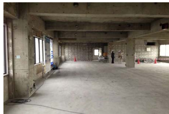
施工前状況②
