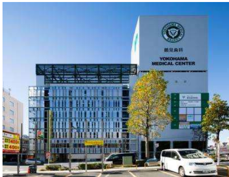
横浜メディカルセンタービル（コンバージョン）
