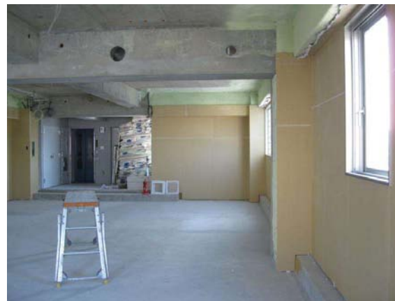
施工前状況②
