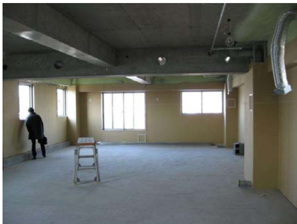
施工前状況①
