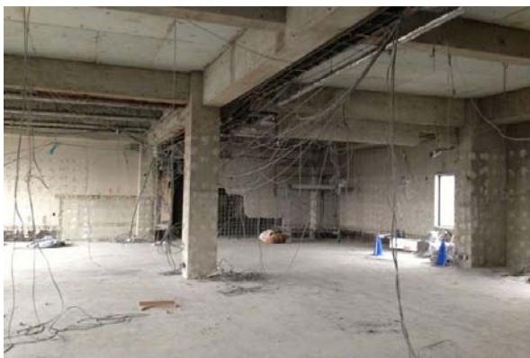
施工前状況①
