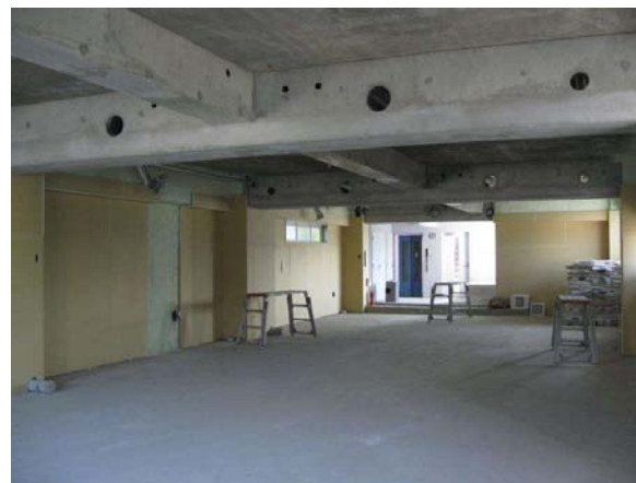
施工前状況③
