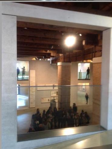
プンタ・デラ・ドガーナはサンマルコ広場対岸の運河に挟まれた島の先端にある歴史的建造物（旧税関倉庫）を、ピノー財団＋安藤忠雄のコンビがコンペで選ばれ現代アート的美術館へ改修された建物である。安藤忠雄が建物内部改修を担当しており、既存煉瓦や石の壁を一つ一つ剥がしながら綺麗に直し、屋根を支える木のトラスを一本一本バラしながら補修していく手間をかけ綺麗にした空間を、コンクリート打ち放し壁で切り取りながら視線をつないでいる空間構成はニューヨーク現代美術館（MOMA）をも感じる。外観は既存のままであるが、建物内部に入ると初めに既存の高い天井（屋根を支える木のトラス組）と古いレンガ壁の空間にトップライトから優しい光が差し込む中にコンクリートとガラスでシンプルに作られた階段が気持ち良い。妻側に有る半円形の窓は壁に囲まれた薄暗い中に差し込む光の演出と共にベネチアを感じさせる外側の景色を覗き見たくなる。既存煉瓦壁と屋根・床を支える木の梁・トラス組の質感とコンクリート打ち放し壁・シンプルな床・ガラスの手摺が、互いを引き立たせ合いながらも落ち着いた居心地の良い空間で時間を忘れさせる。 （宮原 直行）
