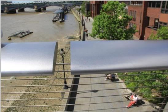
当時は歩行の際に発生する激しい横揺れが問題で開通わずか3日後に閉鎖されてしまったらしいが、現在は通路下部に衝撃吸収のダンパーを設置し、安全に通れるようになっている。
